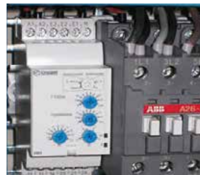
Elektriskt överlastskydd / Electronic load limiter.
