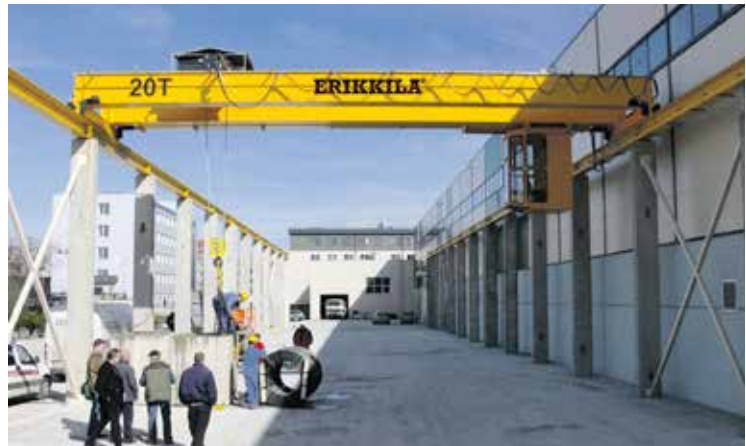
ÖVERLIGGANDE TRAVERSKRAN/OVERHEAD BRIDGE CRANE
